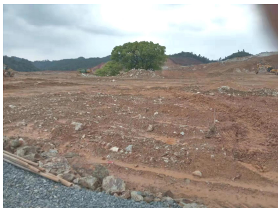
项目西面现状
