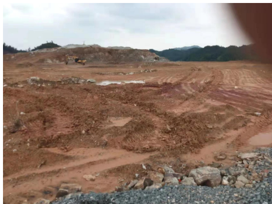
项目东面现状
