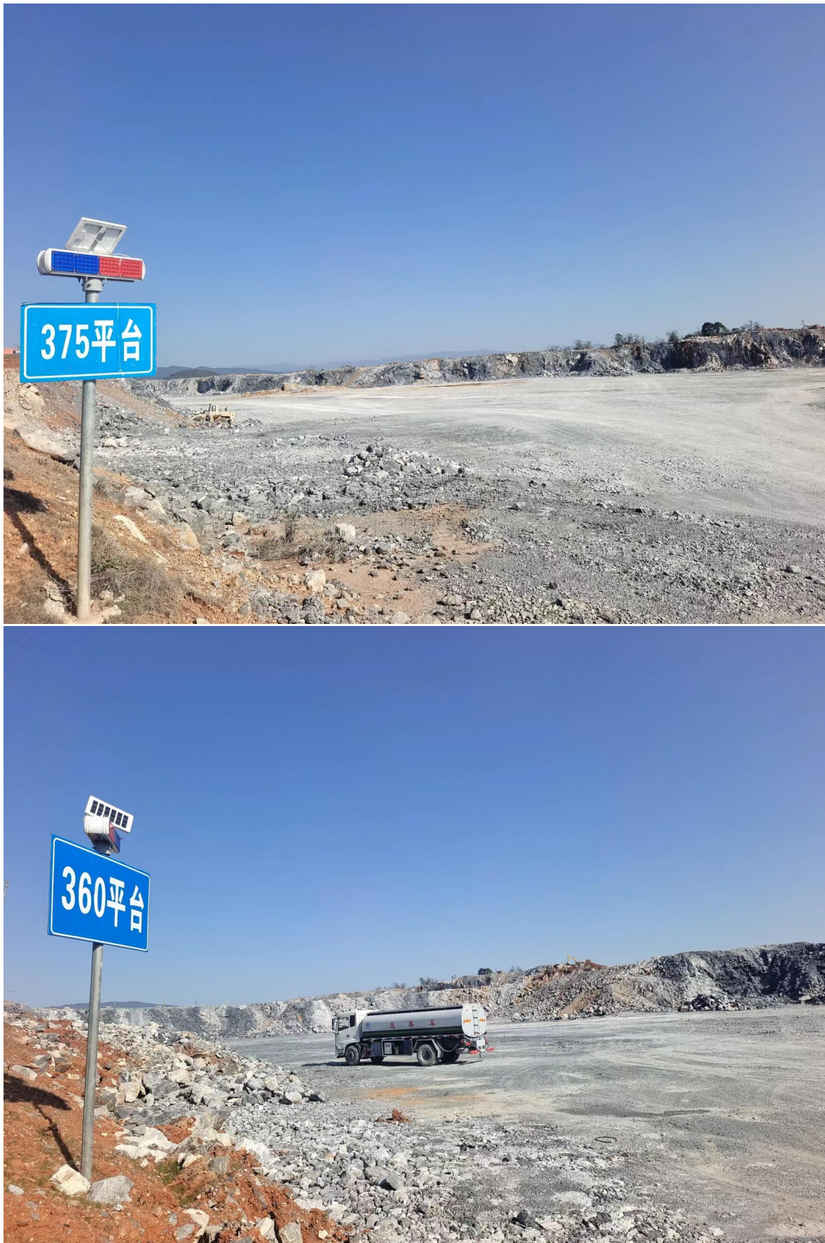
图 2-3 矿山采场（+390m 凿岩平台、+375m 铲装平台、+360m 铲载平台）
