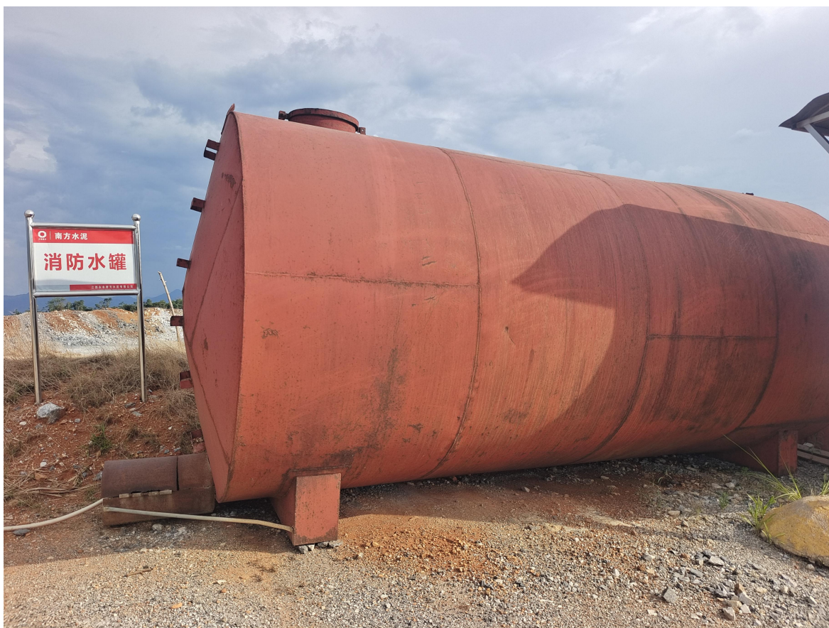
图 2-5 高位水池及水罐
