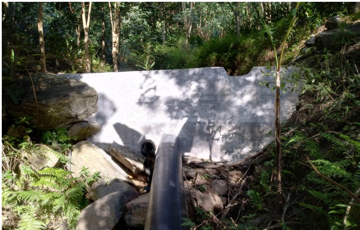
图 2-8 尾矿库 1#挡水坝
