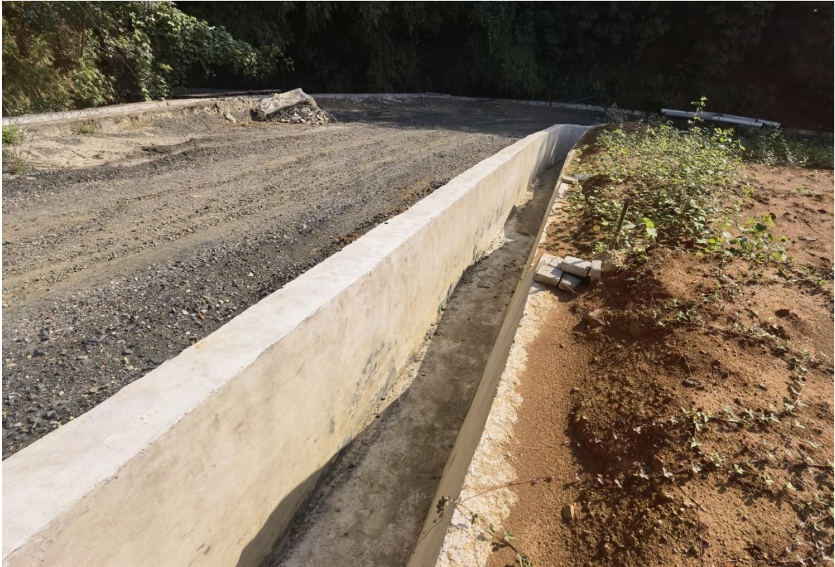
图 2-20 堆积坝坝肩排水沟及上坝道路
