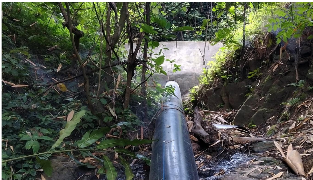
图 2-9 尾矿库 2#挡水坝
