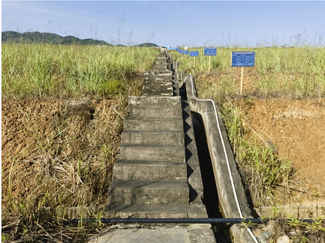
图 2-18 堆积坝人行踏步及坝坡排水沟
