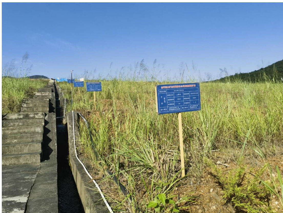
图 2-28 尾矿库堆积子坝标识牌
