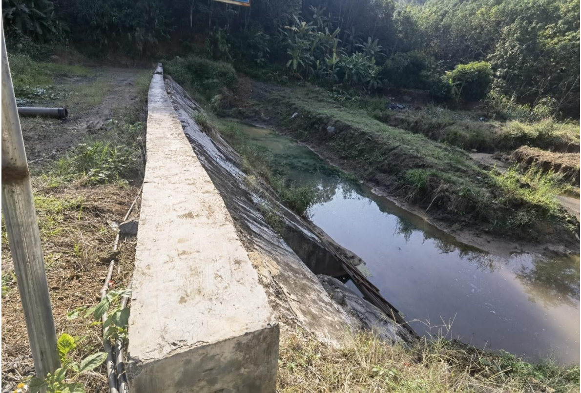
图 2-10 尾矿库 3#挡水坝
