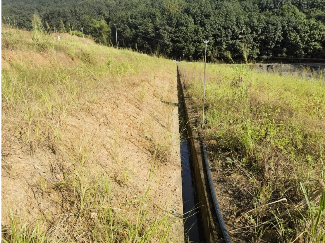
图 2-19 堆积子坝坝面横向排水沟
