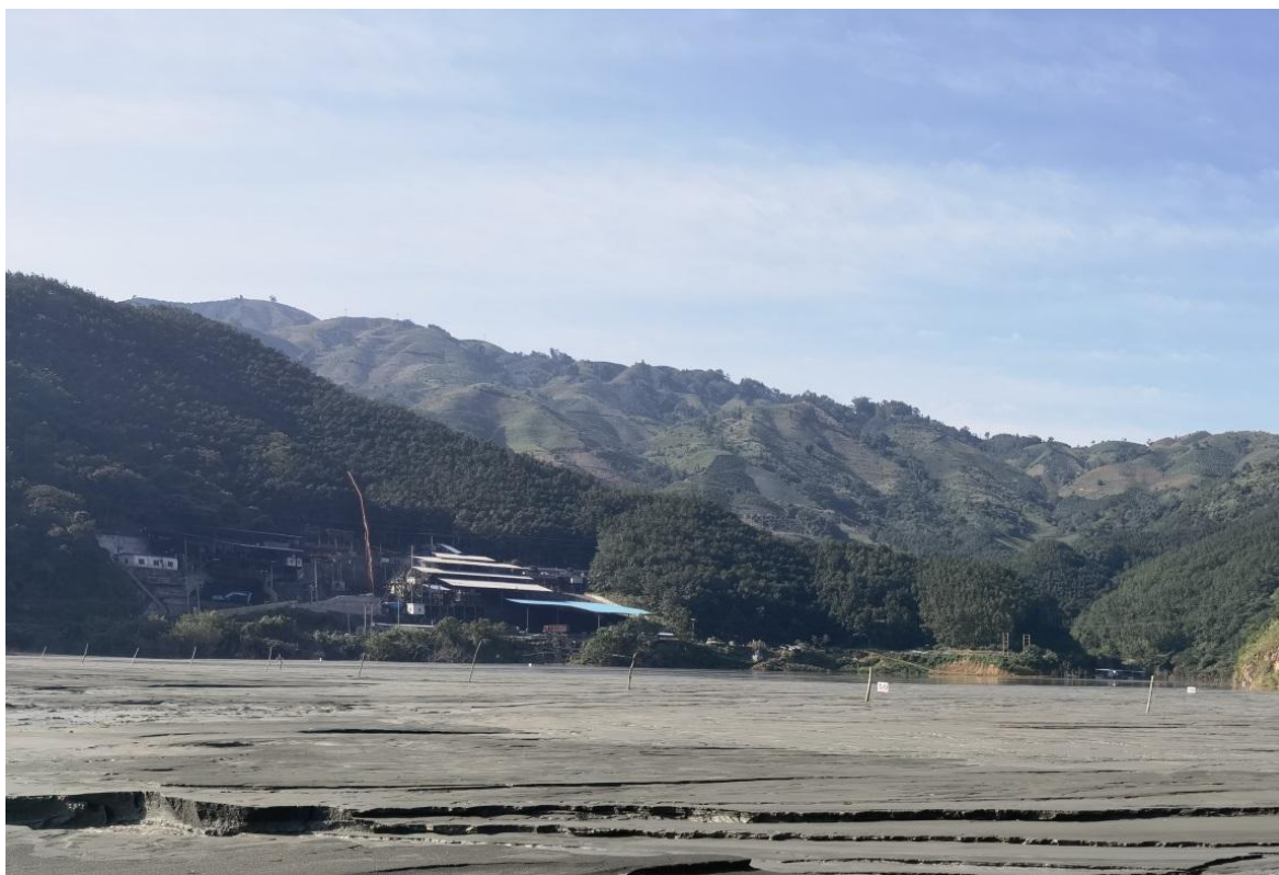
图 2-29 坝面干滩标识牌
