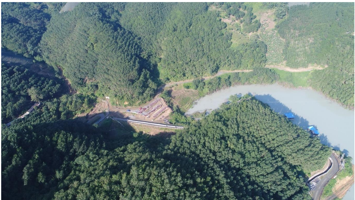
图 2-5 尾矿库库尾澄清水区及移动式回水泵站
