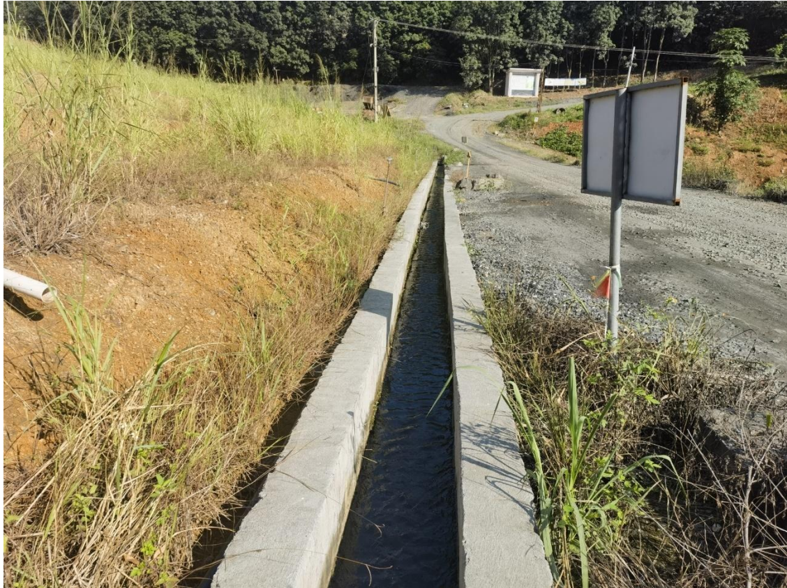
图 2-7 初期坝顶道路及坝面排水沟
