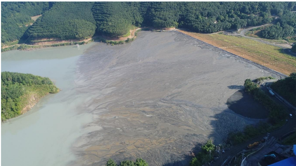
图 2-3 尾矿库初期坝、尾矿坝基及滩面
