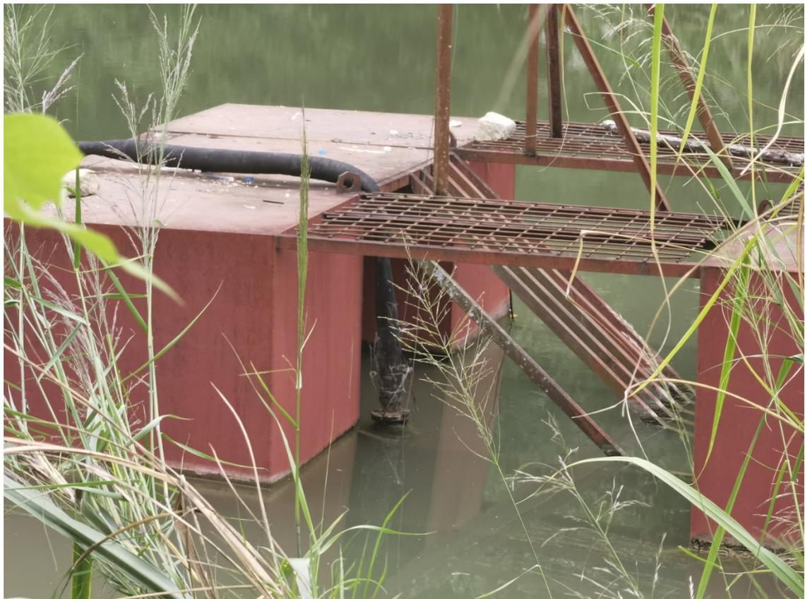
图 2-17 澄清水区回水泵及回水平台
