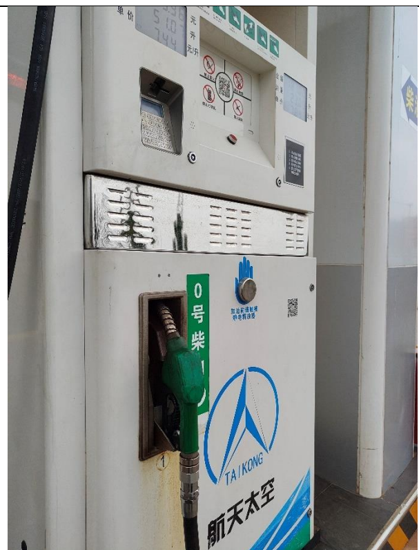
图 2-13、图 2-14 加油机拉断阀
