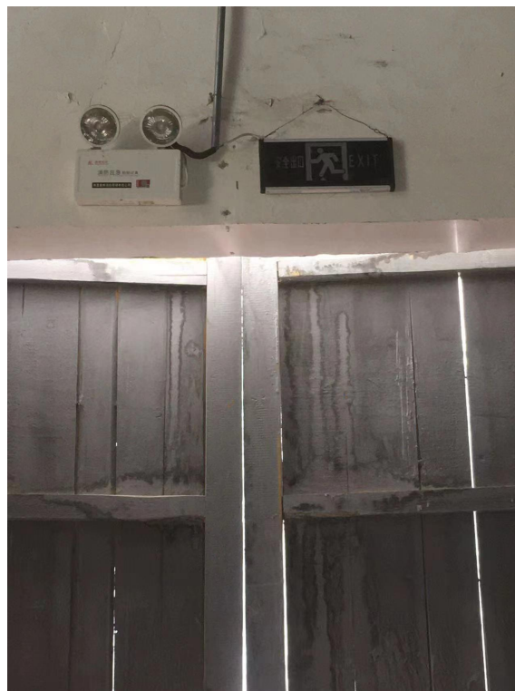
整改后：7号成品库出入口处的 应急指示灯已安装牢固
