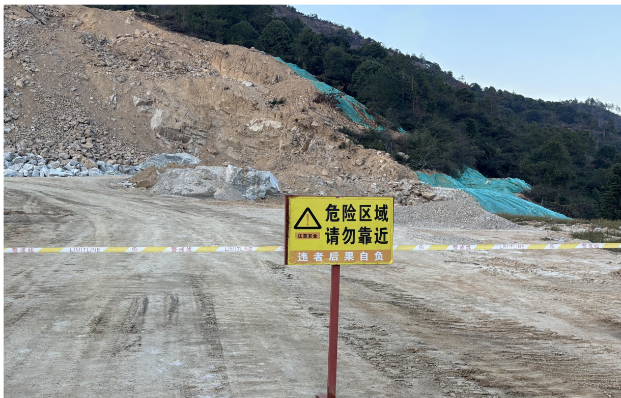
图 2-4 底部平台封堵
