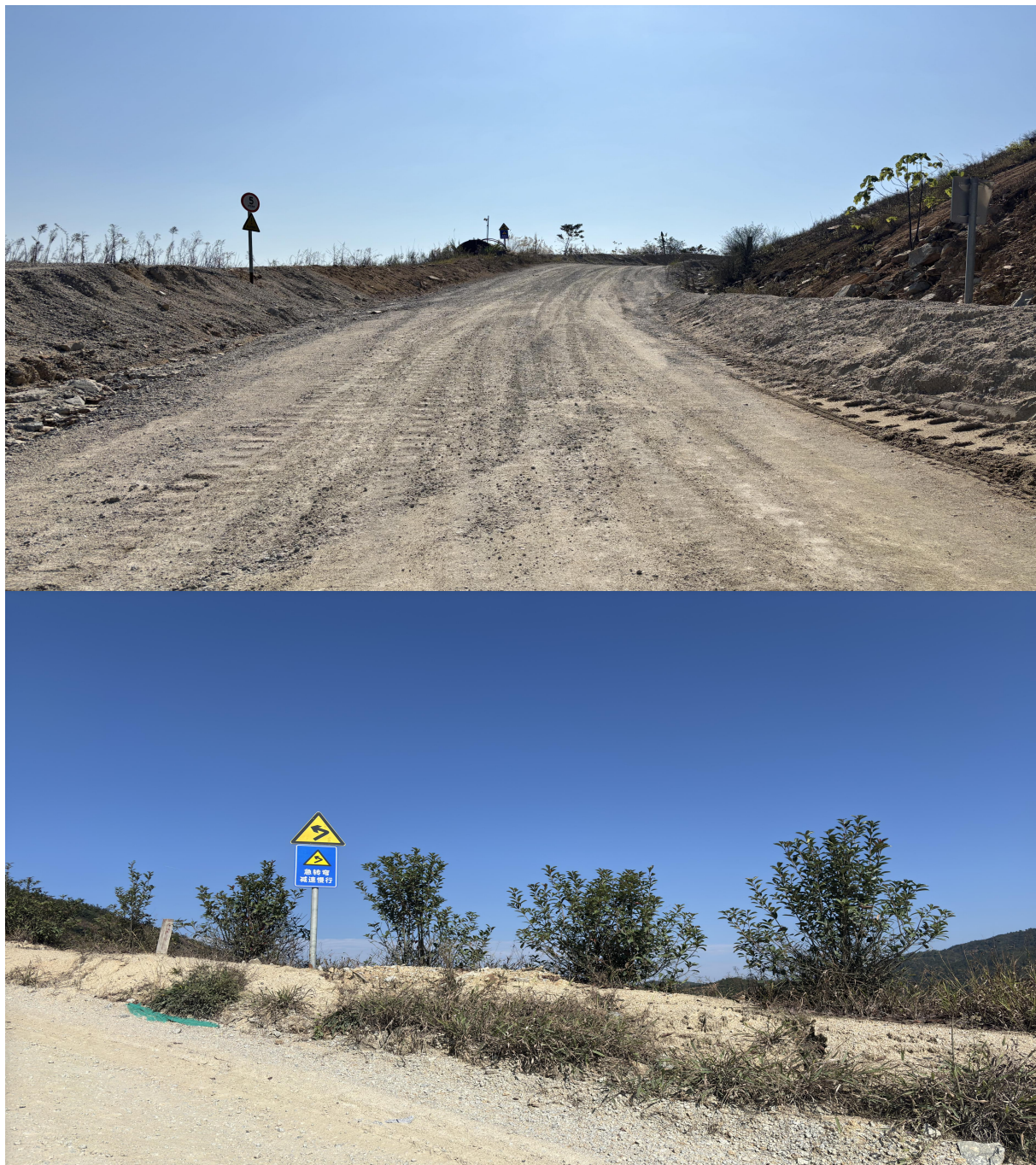
图 2-5 运输公路安全车挡和安全警示标志
