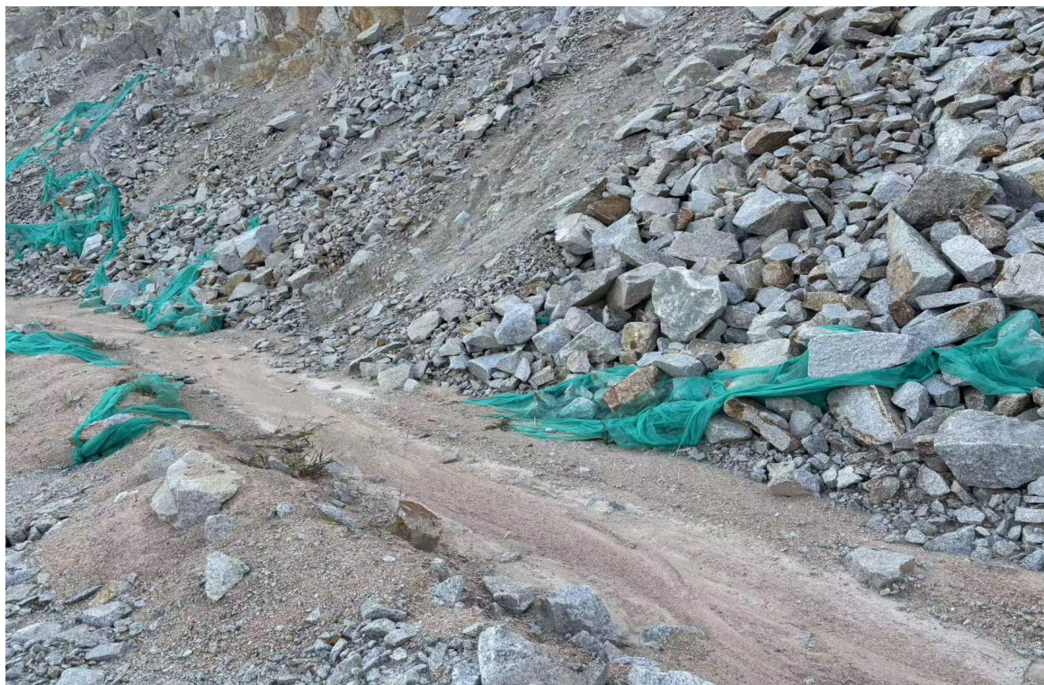
图 2-8 平台内侧排水沟
